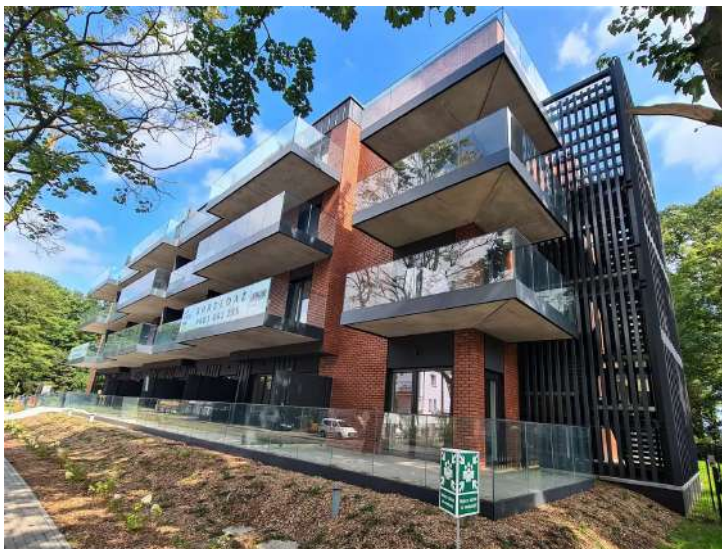
Apartamenty Świnoujście - realizacja dla JAKON Sp. z o.o. - 2023
