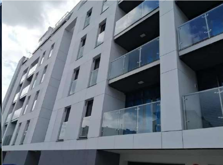
Budynek wielorodzinny - realizacja dla BUDIMEX S.A. - 2019r.
