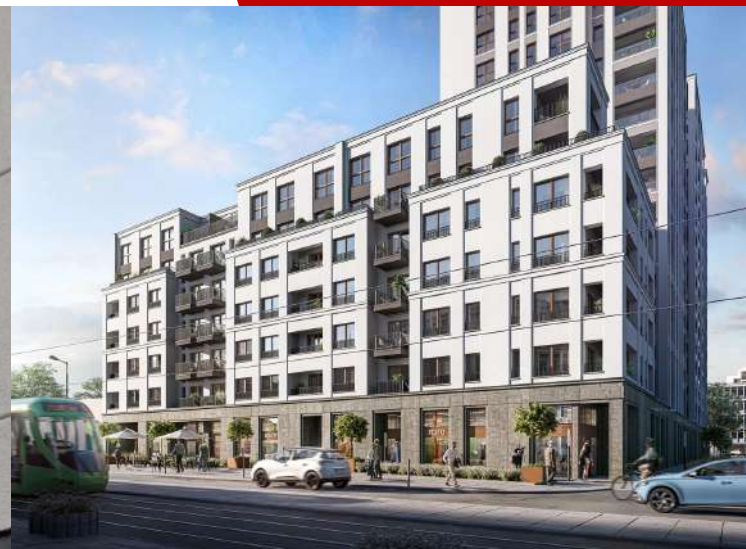
Budynek wielorodzinny - realizacja dla BUDIMEX S.A. - 2022r.
