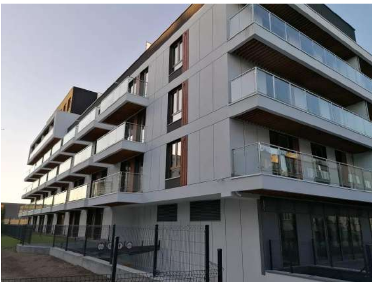
Budynek wielorodzinny - realizacja dla ERBUD S.A. - 2020r.
