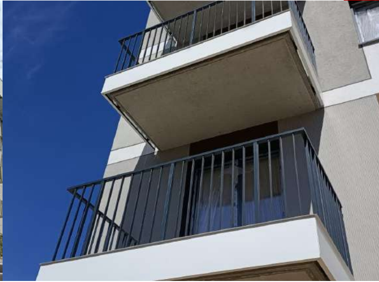
Budynek wielorodzinny - realizacja dla ERBUD S.A. - 2022r.
