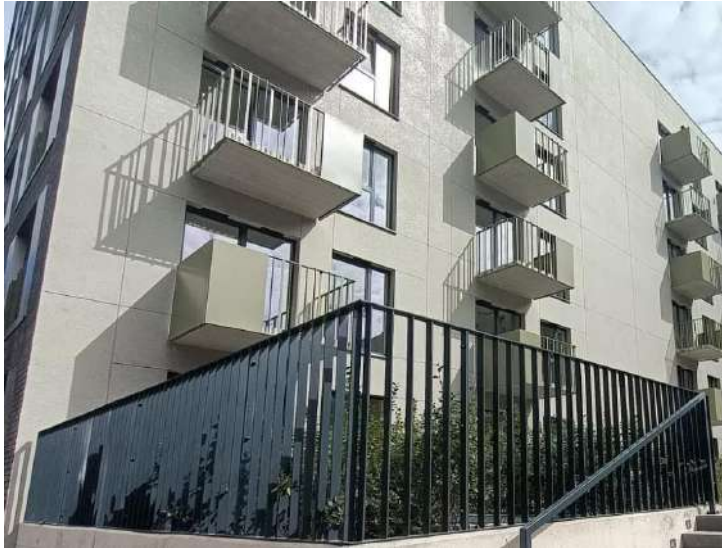
Budynek wielorodzinny - realizacja dla ERBUD S.A. - 2021r.
