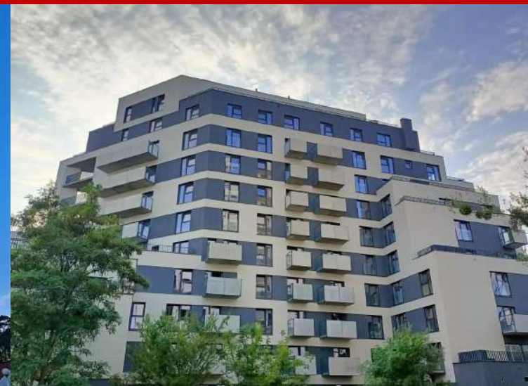
Budynek wielorodzinny- realizacja dla Nickel Development - 2023r.
