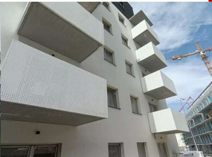
Budynek wielorodzinny - realizacja dla UNIBEP S.A. - 2022r.
